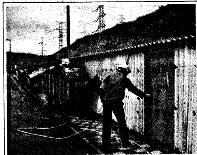
核一廠的「冷凝舊管去汙工作棚」，被中央民意代表稱作「地下工廠」。(記者方儂／攝影)
