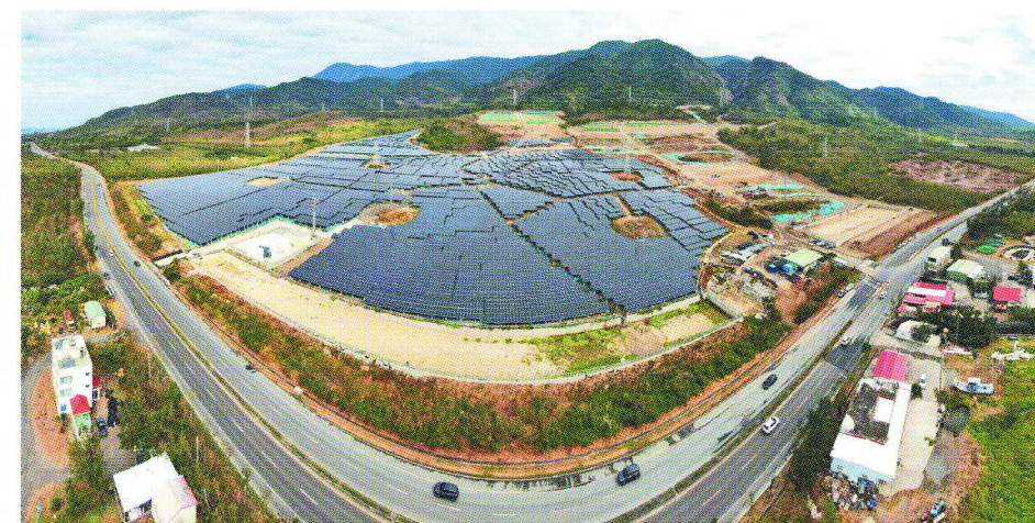
屏東光電四處擴張，在地青農批評種電種到失心瘋，老農離農、也變相迫遷青農的副作用逐漸顯現。圖為車城鄉雞鵝公路旁的山坡地大規模光電案場持續施工的現況。
