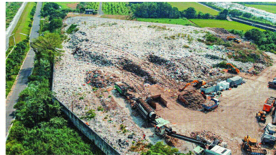
雲林垃圾堆積如山難去化，縣府三年前引進SRF系統，把家戶垃圾破碎後篩分出適合燃燒的廢棄物，賣給業者取代鍋爐燃料，改善垃圾囤積問題。 記者黃仲裕／攝影
