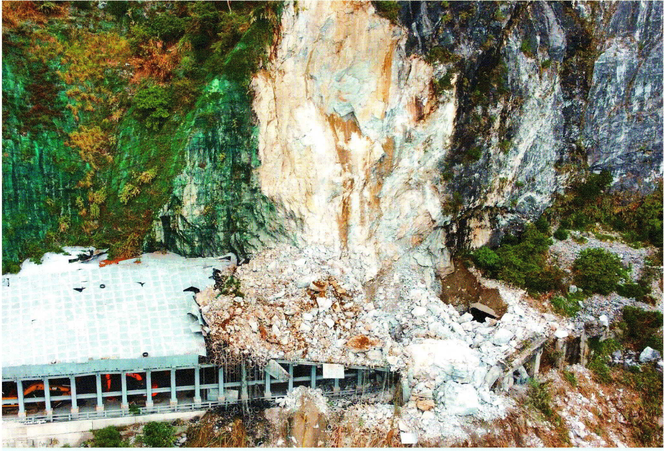
台九線蘇花公路大清水隧道南口前天深夜坍方，壓垮隧道口，巨石堆疊達五公尺高，公路總局派重型機具搶修，預估十五日傍晚可搶通。新聞見B1 文／王燕華 圖／許正宏
