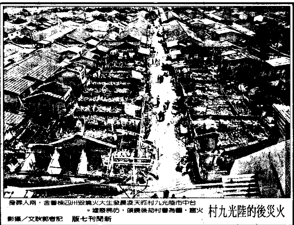
村九光陸的後災火：火災發生後，村內房屋被燒毀，現場一片狼藉。
