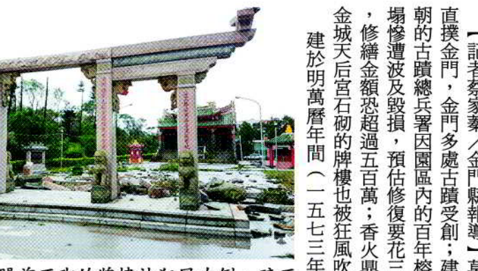
金城天后宮門前石砌的牌樓被狂風吹倒，碎石散落一地。記者蔡家豪／攝影
