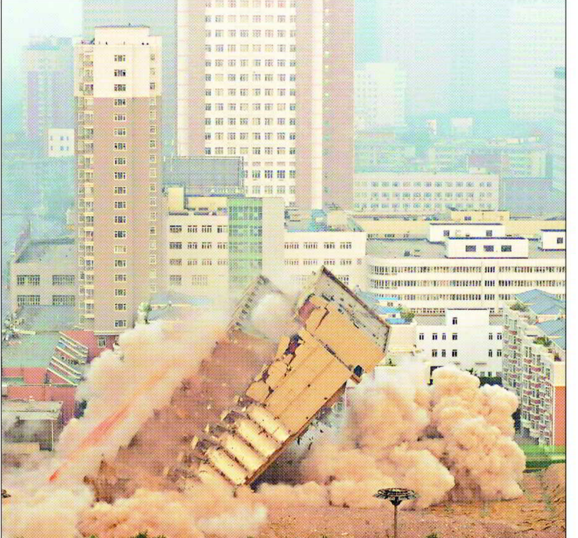
看他樓倒了 瀋陽陽山賓館的18層大樓昨天進行爆破，整棟大樓傾倒而下。(新華社)
