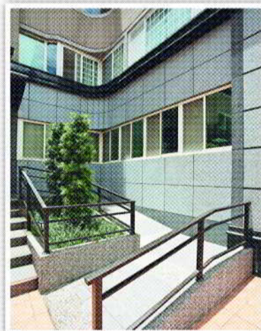
拉皮後，慶祥大廈在入口處增設無障礙設施。
