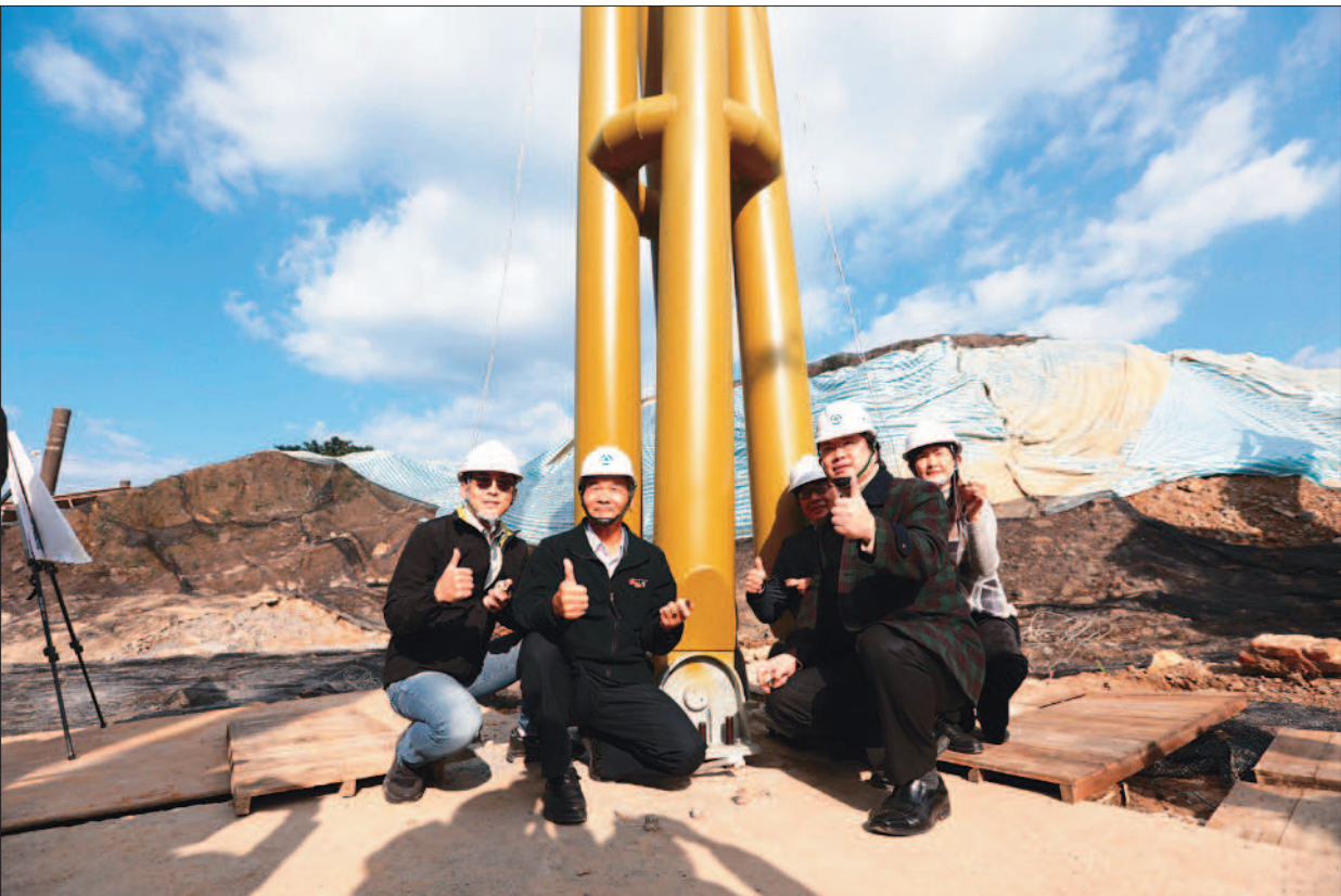
←基隆轉運站工程預計今年八月完工，市長林右昌十八日為頂棚首支鋼柱吊裝組立鎖固螺絲。(基隆市政府提供)
