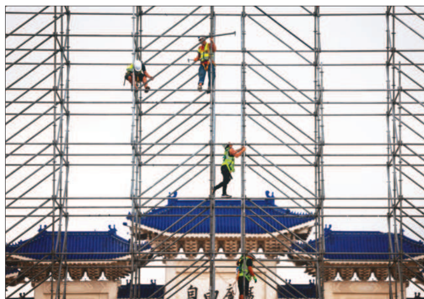
↑根據中央氣象署網站，截至25日下午2時許，最高溫為屏東春日攝氏38度，圖為台北市中正區工人在豔陽高溫下施工作業一景。(中央社)
