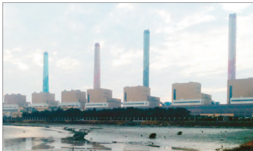
↑台中火力發電廠本週全面盤查廠房設備，台電發現七號機爐管多處變形易位，機組持續停機維修。(記者陳金龍攝)
