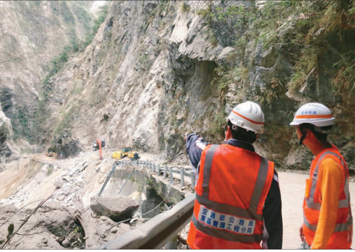
→花蓮強震造成台八線中橫公路中斷，交通部公路局東區養護工程分局分別從東、西端同時搶通，五日下午三時，西端已從大禹嶺挺進天祥。圖為台八線一七三公里處九曲洞隧道災害搶修情形。(公路局東區分局提供)
