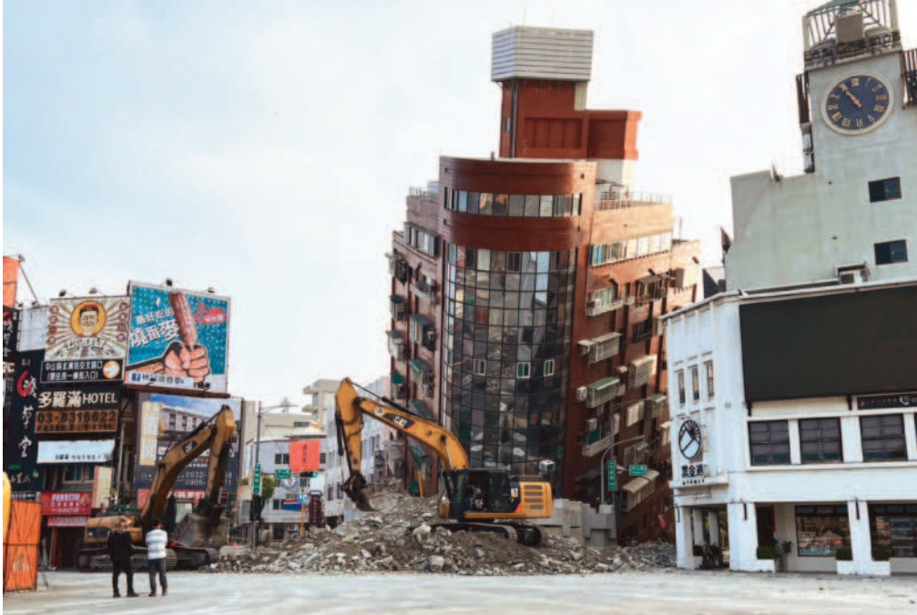
↑花蓮強震傾斜的天王星大樓導致一人喪生，檢查官將蒐證釐清責任，暫不拆除。縣府四日上午持續以消波塊和砂石穩定，防止大樓傾倒。(中央社) ↓民眾震後拍下太魯閣燕子口步道狀況。(民眾提供，中央社)
