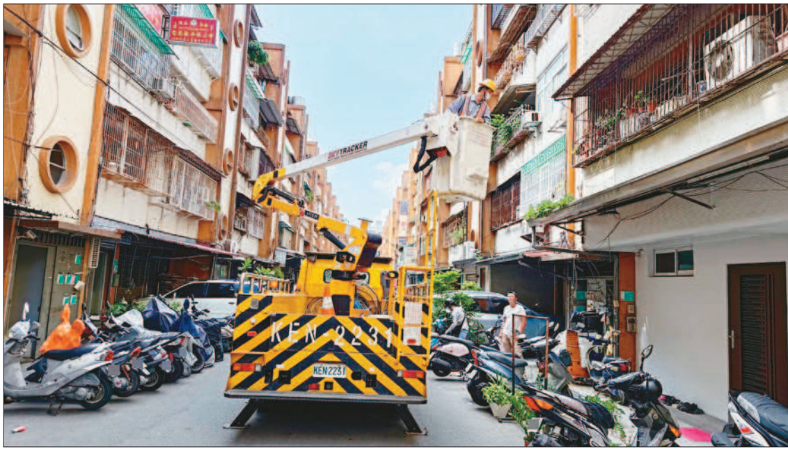
←台南市登革熱疫情延燒，全市累計破萬例，市府出動高空作業車巡檢高風險鄰里天溝，預防性投藥。(台南市政府提供)
