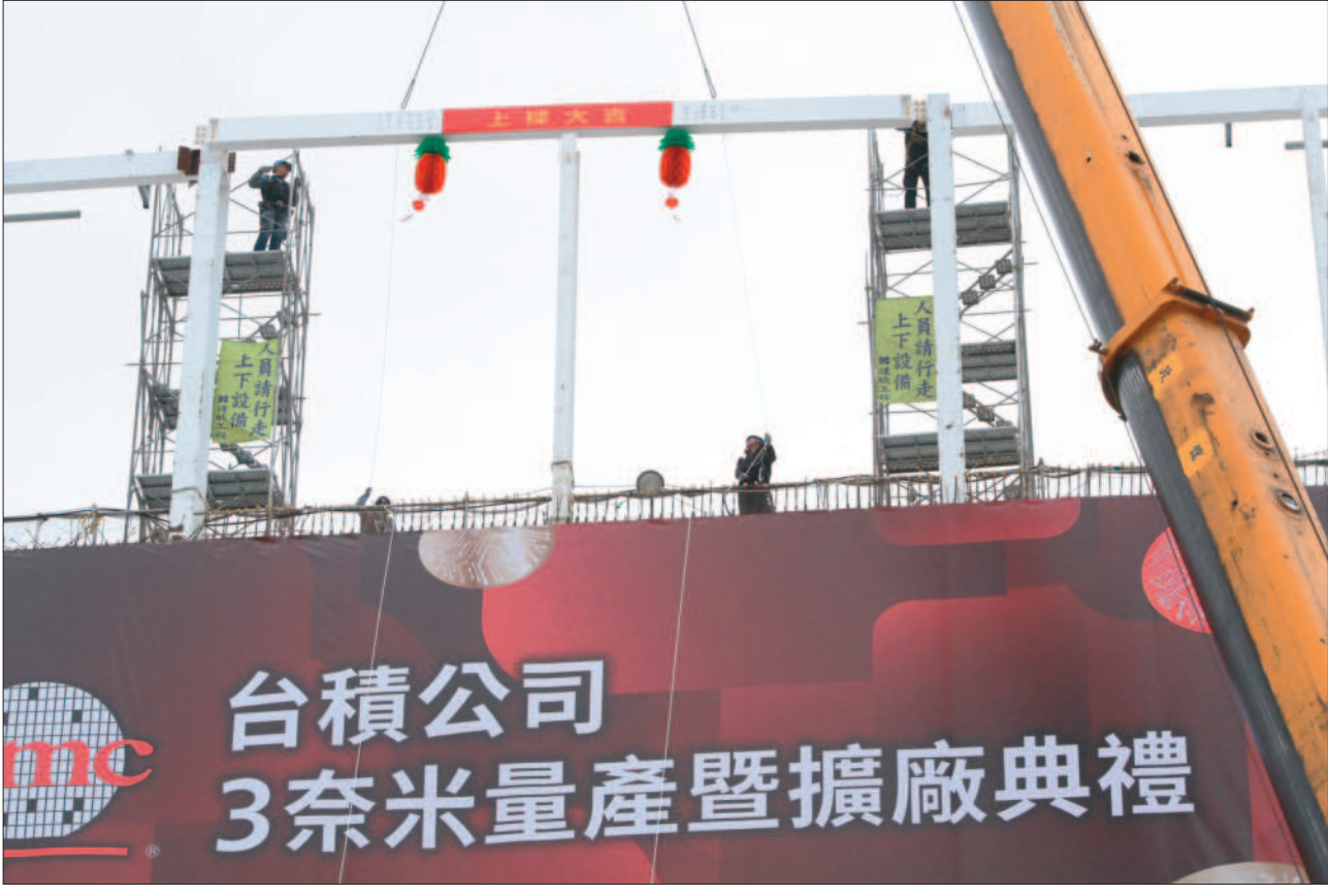
→台積電3奈米量產暨擴廠典禮，進行擴廠上梁儀式。（中央社）
