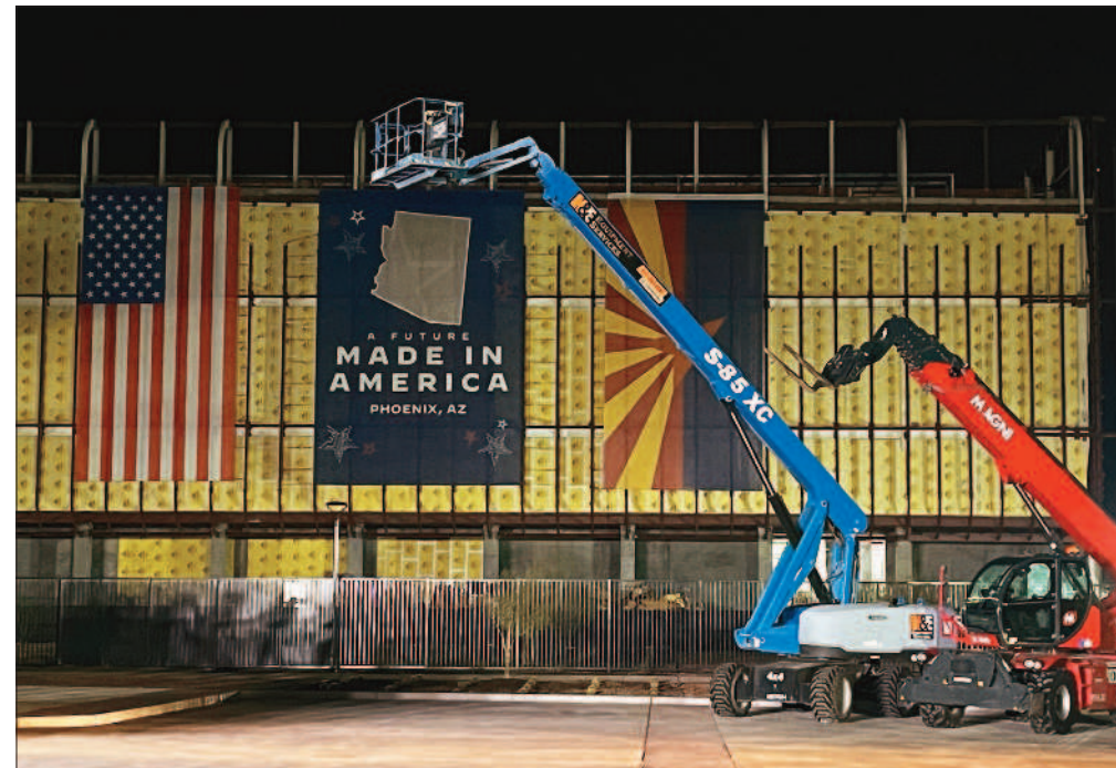
←台積電宣布亞利桑那州廠開始興建第2期工程，預計2026年開始生產3奈米製程。圖為台積電在美國鳳凰城的5奈米廠進行移機典禮現場布置情形。(中央社)
