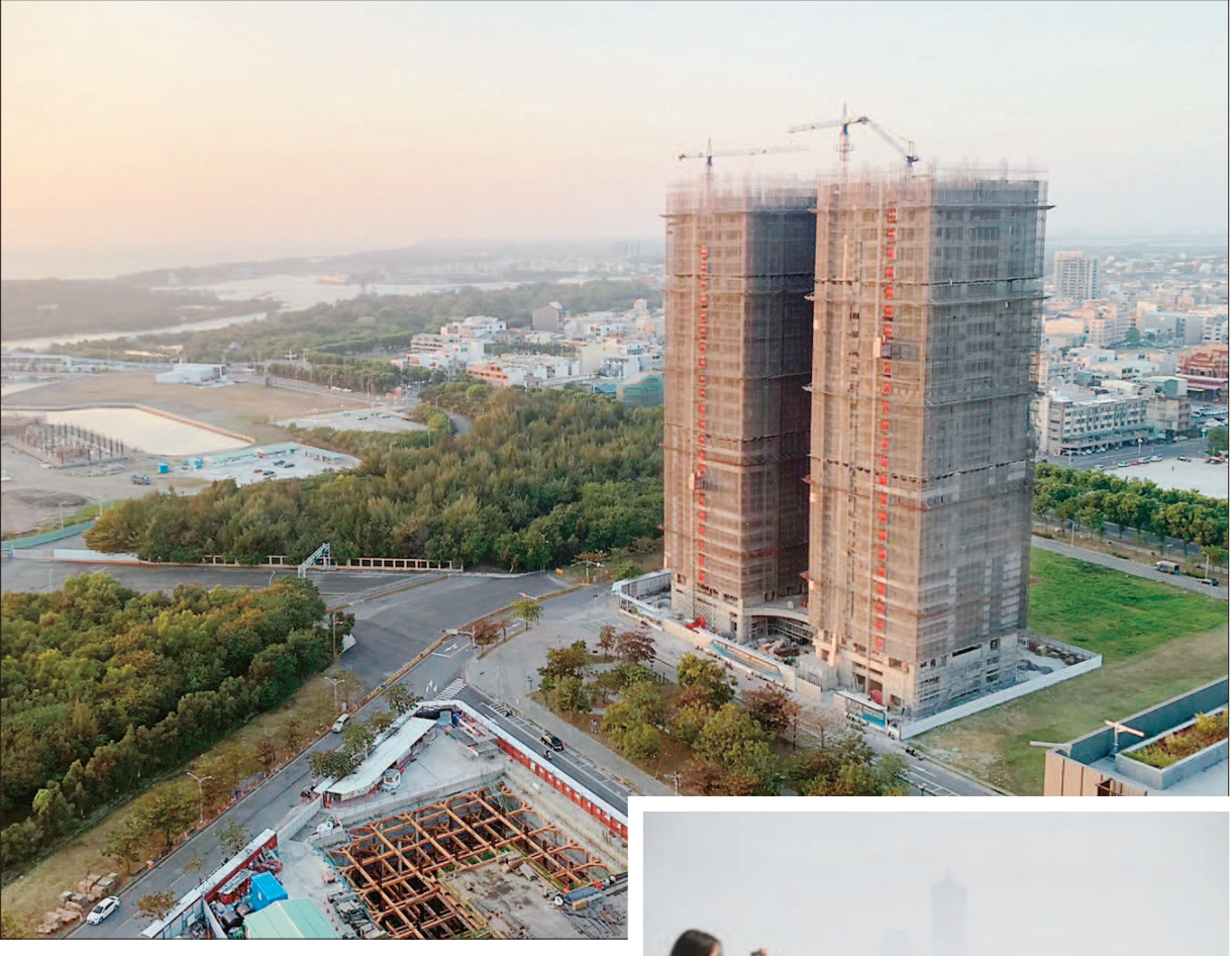
↑ 根據主計總處統計，110年8月底營建工程業職缺率飆上5.14%，創下歷年同期新高。 (記者姚正玉攝)
