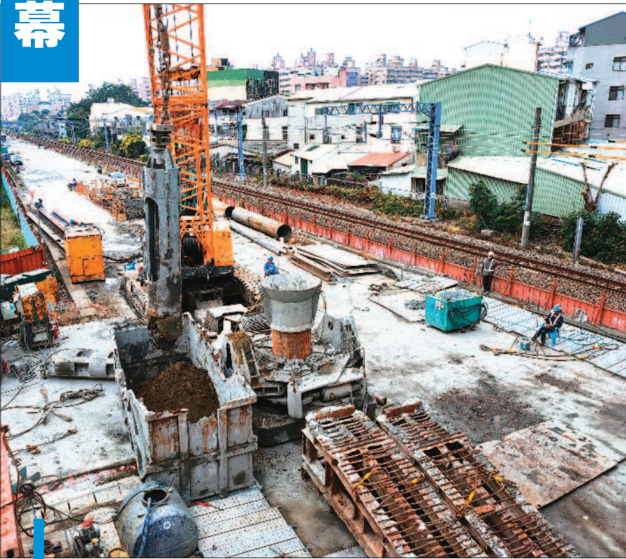
↑台南市區鐵路地下化工程，北區黃春香兩戶拆除後，鐵道局將趕工，預計2026年底整體工程完工。(記者林雪娟攝)
