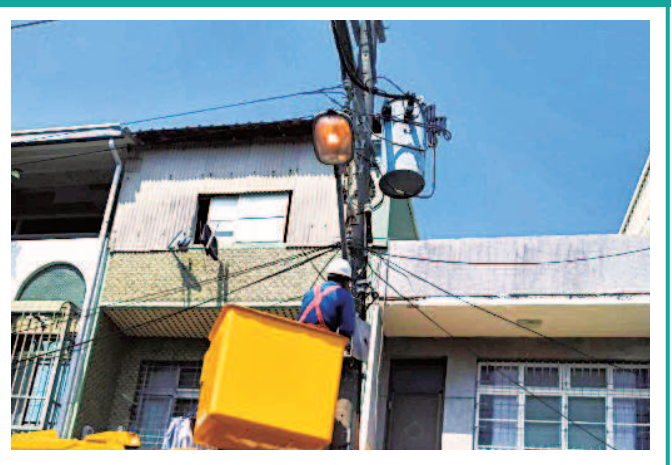
↑南市府積極推動換裝LED路燈建置工程，並導入智能路燈維護管理系統即時維管。
