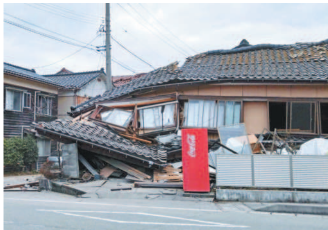
▲日本石川縣昨天發生七點六強震，造成道路崩裂，房屋倒塌。
