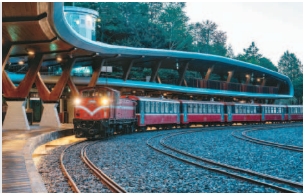
▲阿里山祝山車站完成改建工程後，將在二十日重新啟用。 圖片提供／林鐵及文資處
