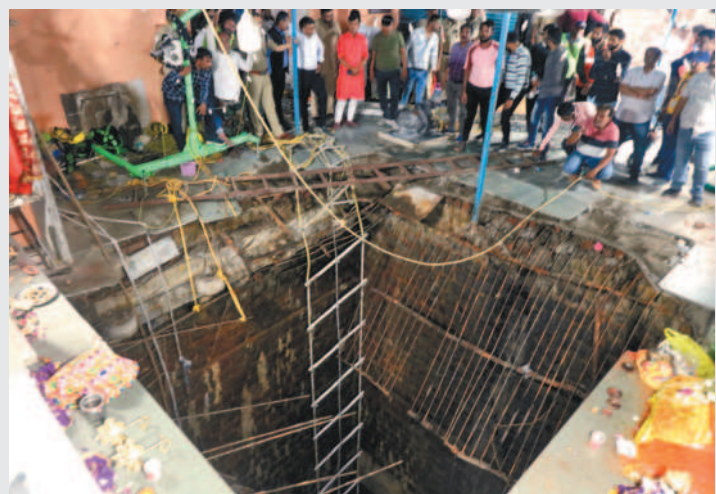
印度寺廟地板坍塌 信徒墜井36死
