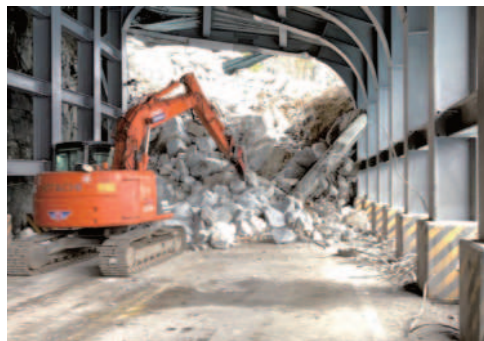
▲►蘇花公路大清水隧道昨天凌晨發生坍方，大量土石崩落壓毀明隧道，公路總局全力搶修，預計十五日傍晚才可搶通。 圖片提供 / 公路總局
