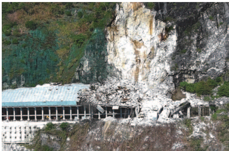
▲►蘇花公路大清水隧道昨天凌晨發生坍方，大量土石崩落壓毀明隧道，公路總局全力搶修，預計十五日傍晚才可搶通。 圖片提供 / 公路總局
