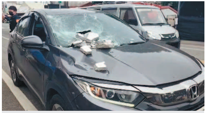
▲地震造成花蓮市一家飯店外牆瓷磚掉落，砸破一輛路過轎車的擋風玻璃，幸好沒有人受傷。 報導 / 徐庭揚 圖片提供 / 民眾
