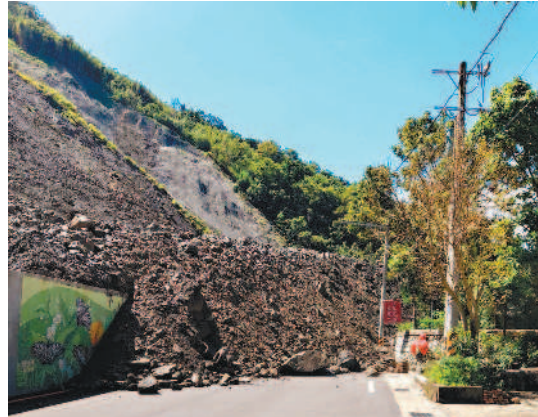
▲璨樹颱風過後，新竹縣秀巒國小正後方的山坡昨天早上土石流加劇，師生緊急撤離。 圖片提供／秀巒國小
