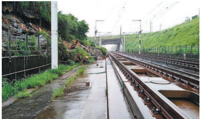
▲高鐵苗栗邊坡崩塌，幸好有入侵偵測告警系統，第一時間讓附近列車停駛。 圖片提供／高鐵 ◀有臺版「地中海」之稱的馬祖北竿鄉芹壁村，圖左上角的中山國中下方邊坡土石坍塌，汽車隨著土石往下滑落，泡在泥水中。 圖片提供／北竿民眾
