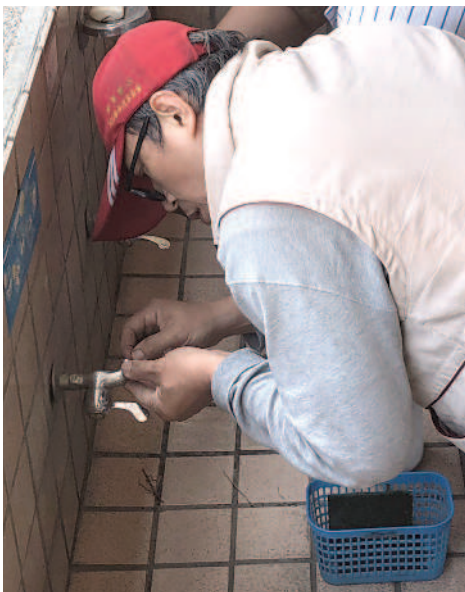
▲►嘉義市世賢國小為了方便學生勤洗手，學校水電技工昨天將水龍頭噴霧式省水設施卸下，提高流量（右圖）。上圖為卸下節水器後的水龍頭。 圖片提供/世賢國小
