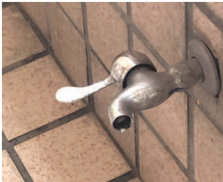
▲►嘉義市世賢國小為了方便學生勤洗手，學校水電技工昨天將水龍頭噴霧式省水設施卸下，提高流量（右圖）。上圖為卸下節水器後的水龍頭。 圖片提供/世賢國小
