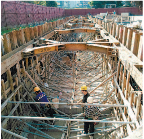
▲►三重高中興建一座四百噸的地下貯水池（右），施工完成可見一片綠油油的校園（左）。 圖片提供／新北市政府
