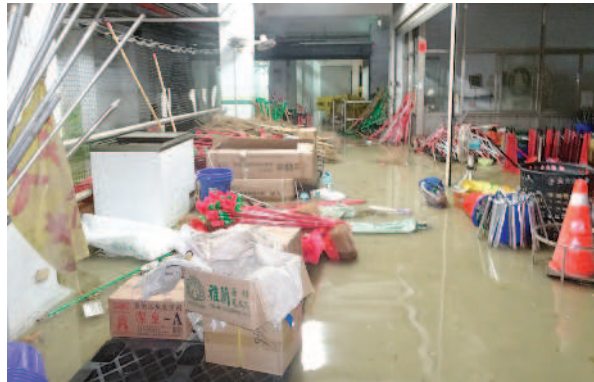
▲臺南市崇明國中地下室淹水二十公分, 災情最為嚴重。 圖片提供/臺南市教育局
