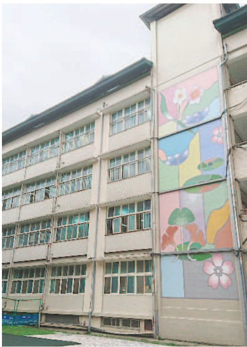
▲新北市豐年國小以「擴柱」、「剪力牆」、「翼牆」工法補強校舍結構。圖為採剪力牆工法的校舍。圖片提供／豐年國小
