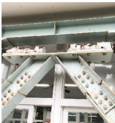
▲臺東縣新港國中校舍老舊，建築結構體有裂縫，且牆面剝落，學生上課安全問題令人擔心（左圖）；為了補強校舍建築安全，學校以阻尼器補強校舍結構取代重建（上圖）。 圖片提供／新港國中
