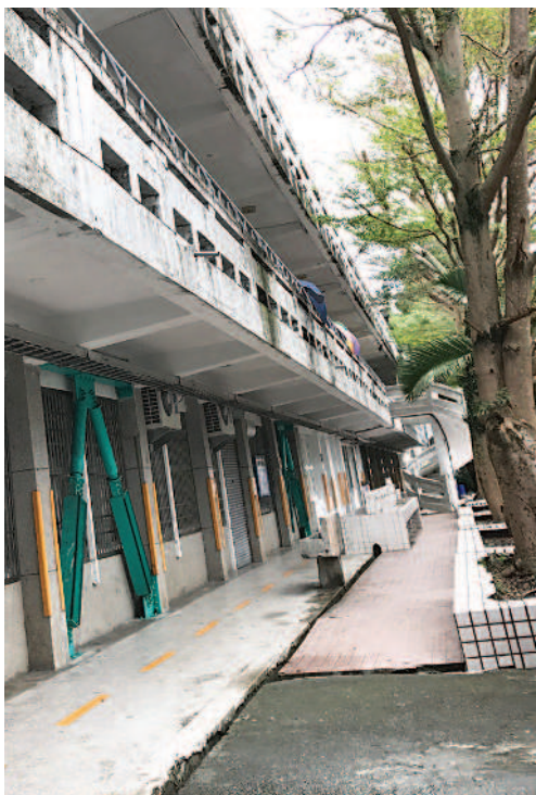
▲臺東縣新港國中校舍老舊，建築結構體有裂縫，且牆面剝落，學生上課安全問題令人擔心（左圖）；為了補強校舍建築安全，學校以阻尼器補強校舍結構取代重建（上圖）。 圖片提供／新港國中
