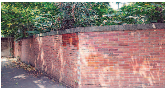
▶ 轉角圍牆修復後。
