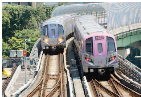
▲全車隊營運測試。圖為機場捷運。
