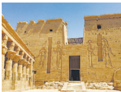
埃及在興建水壩前，先將菲萊神廟逐塊拆下，日後重新組建。
