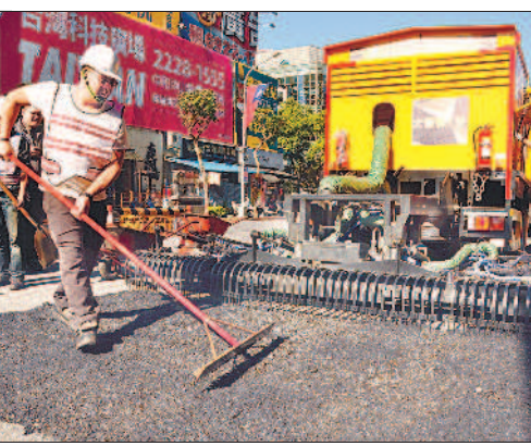
全臺首創熱再生修補車
