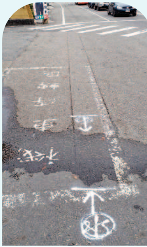
▲在疑似漏水點的地面上，進行鑽孔確認作業。
