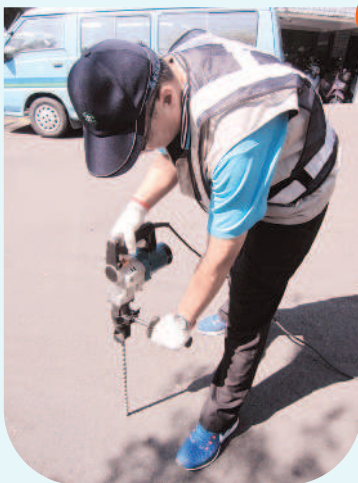
▲在疑似漏水點的地面上，進行鑽孔確認作業。
