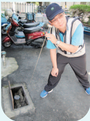
▲以聽音棒貼近水表的管套，聽取漏水噪音。
