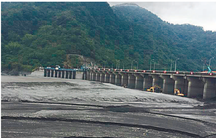
◀經濟部水利署在集集興建攔河堰(右圖)，攔截濁水溪溪水(左圖)，再送到台灣自來水公司林內淨水場，以供彰化、雲林農業、生活及工業用水。
