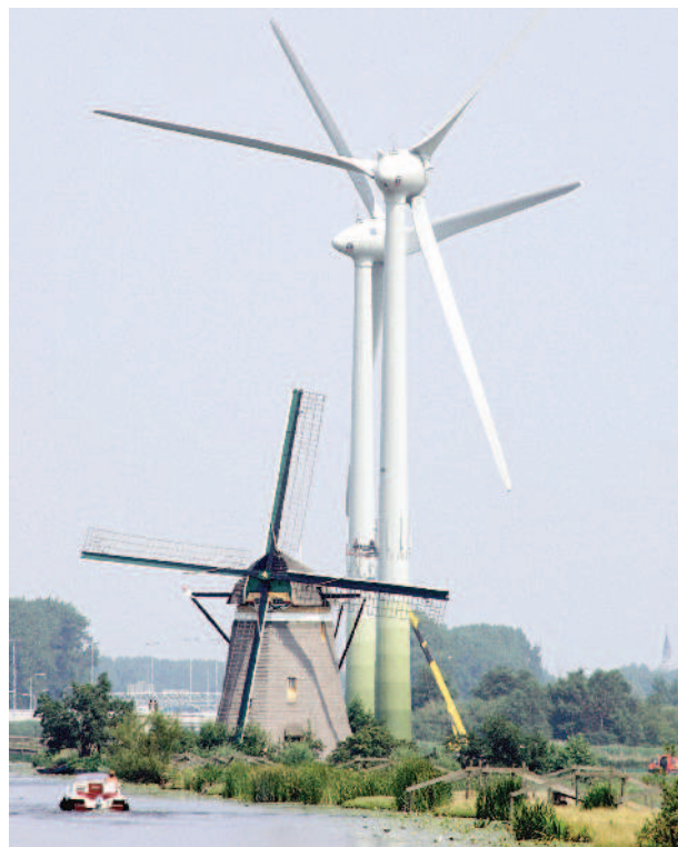
荷蘭早期使用風車排水，如今用風力發電。圖為荷蘭祖特爾烏德的風車與風力發電機。
