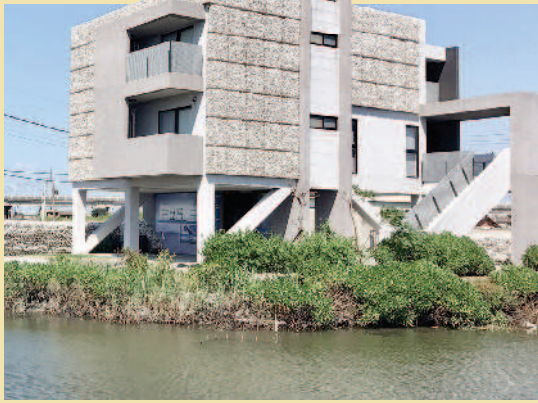
▲高腳屋可以降低淹水災情，是適應低窪地區的建築工法。
