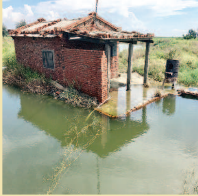
▲高腳屋可以降低淹水災情，是適應低窪地區的建築工法。
