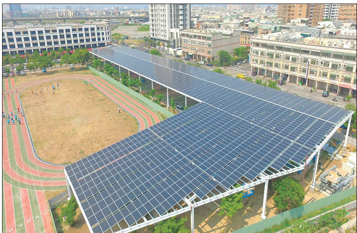
▲高雄市鳳翔國中設置全國首座太陽能光電風雨球場。 圖片提供/體育署
