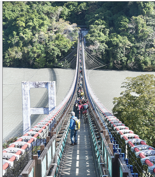
▲桃園市新溪口吊橋高低落差達二十三公尺，在橋低處遠眺橋頭，非常壯觀。攝影/陳中興
