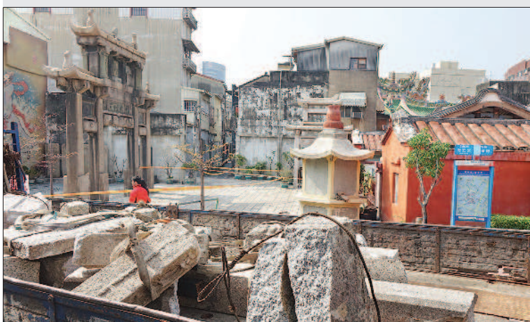
▲臺南市永康區維冠金龍大樓受震傾倒，社工人員在家屬等候區架設白板，寫上傷者名單及就醫院所，以備查詢（上圖）。臺南市多處古蹟受損，位在五條港地區的風神廟前鐘樓坍塌，文化局安排車輛運走殘骸；下圖中左方兩百多年歷史的接官亭則完好。 攝影／詹伯望
