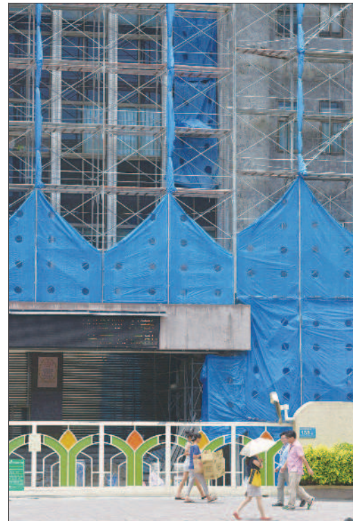
▲每到暑假，學校變成工地，校舍整修之際，安全問題受重視。攝影/高修民
