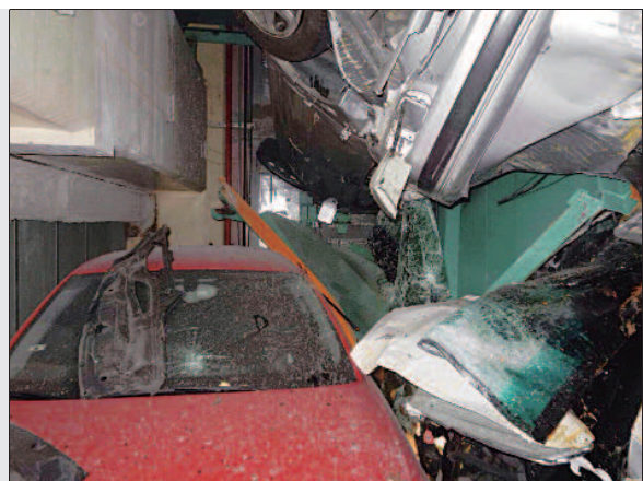
▲臺北市松江路停車場內的汽車坍塌。圖片提供／臺北市消防局
