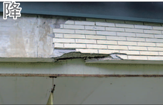
▲桃園市觀音區的樹林國小校舍瓷磚嚴重脫落，校方申請修繕。 圖片提供／樹林國小
