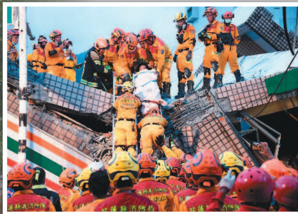
玉里一棟樓房倒塌，壓垮超商，消防人員救出4人送醫。圖/中央社
