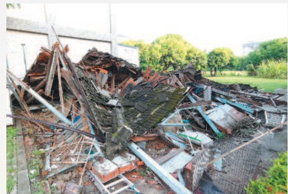
台東市屋齡80年日式老屋倒塌，為少數保留日治時期數島移民村傳統的房舍。圖/卜敏正
