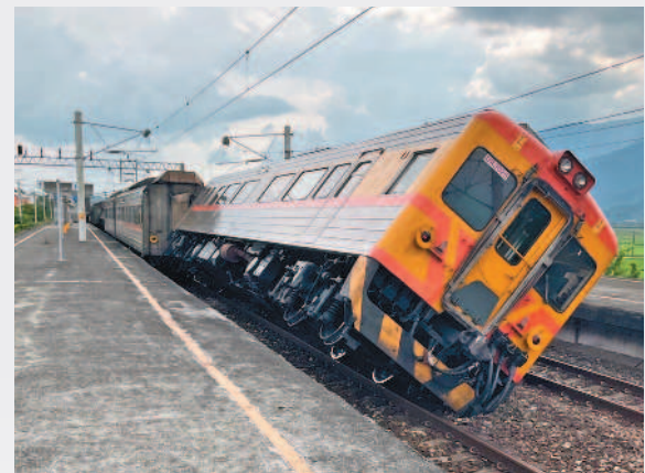
富里台鐵東里站月台雨棚掉落，導致自強號出軌，20名旅客無人傷亡。圖/卜敏正翻攝
