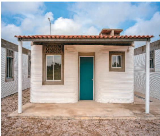
專家認為，單戶型房子正適合測試3D列印房的耐久性及抗震表現。坐落在墨西哥納卡胡卡市的這棟3D列印房，已歷經一場規模7.4的地震。圖／取自網路
