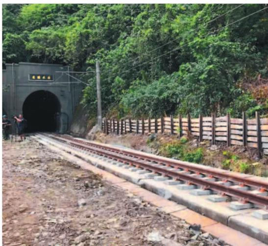
太魯閣號撞車事故地點，目前在清水隧道前鐵軌旁和邊坡，都已打上鋼軌樁作防護。圖/王燕華
