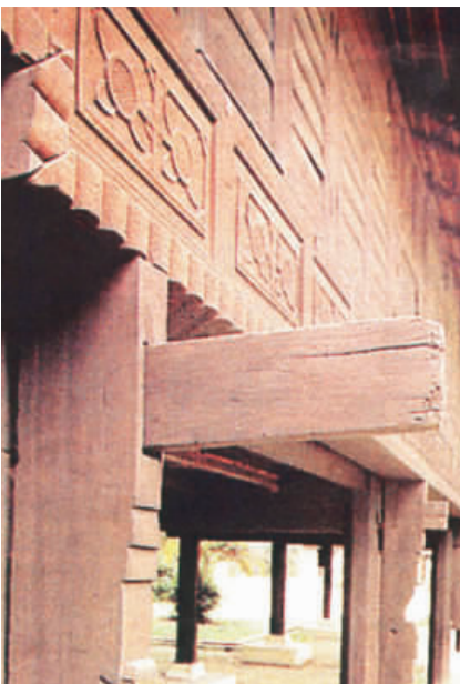
。貌全宮皇釘無 用不示顯，築建部局的宮皇釘無 。巧技榫接的子釘 供提山光佛亞西來馬/圖
